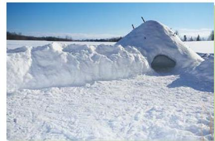
pois de la compacter. La forme idéale du quinzy est un demi-dôme capable d'abriter 2 personnes. Il devrait avoir de 3 à 4 mètres de diamètre sur 2 mètres de hauteur. Insérer une longue branche du sommet jusqu'au sol ainsi que plusieurs branches plus courtes, celles-ci étant insérées de 25 à 30 cm de profondeur un peu partout. Elles serviront de guide pour l'épaisseur des murs (voir l'étape 3 ci-dessous). S'assurer que le sommet du demi-dôme est relativement plat.
