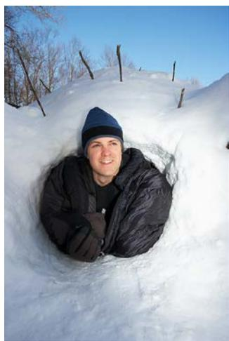
En fonction du vent, déterminer de quel côté sera placée l'entrée. Commencer à creuser du côté opposé au vent et garder l'entrée aussi petite que possible. Creuser un tunnel jusqu'à la branche centrale. À partir de cet endroit, creuser vers l'extérieur jusqu'à l'atteinte des petites branches guides. Par une journée ensoleillée, on percevra la lumière au travers de la neige. La structure devrait être assez solide pour supporter son propre poids et, éventuellement, d'autres chutes de neige.
